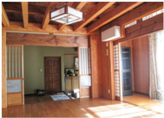
「木質耐震シェルター 70K」の施工事例。木質ならではの空間で耐震シェルターを設置したことが分からないほど溶け込んでいる
